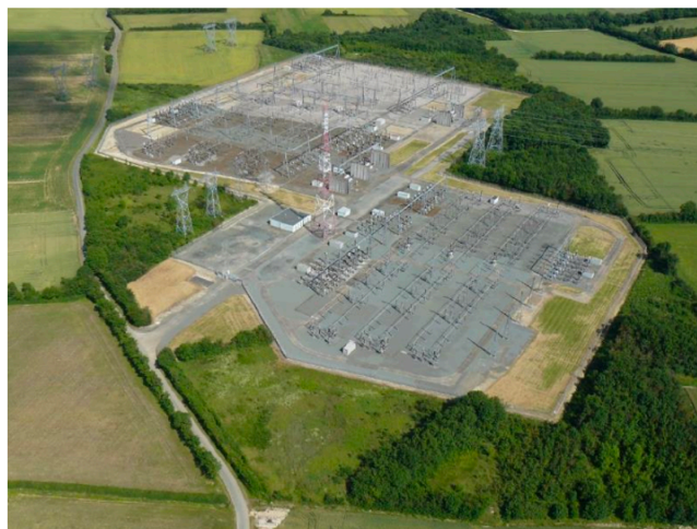
Figure 26 : Poste existant de 225 / 400 kV de GRANZAY dans les Deux-Sèvres (Source : RTE)
